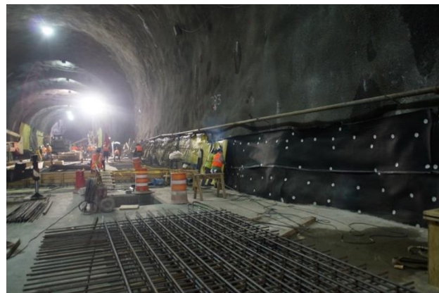
(d) Tunnels (comp. J-Drain)
