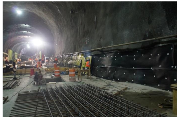
(d) Tunnels (comp. J-Drain)
